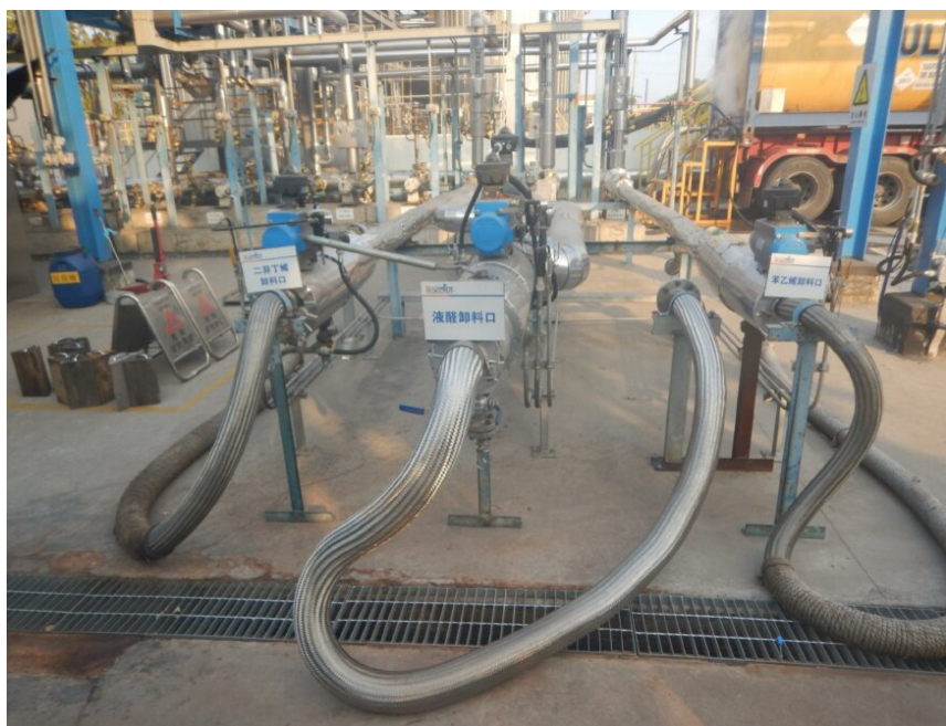
图 4.1-1 罐区西侧卸料口
