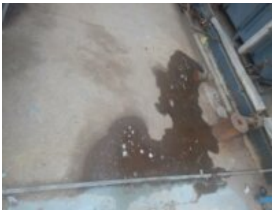
图 4.4-1 污水处理站一处地表
